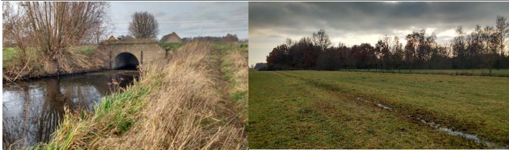
Figuur 5: links, de duiker onder de Steinse dijk is momenteel afgesloten met een tussenmuur. Rechts: een natte depressie in het terrein waar een greppel gerealiseerd kan worden
